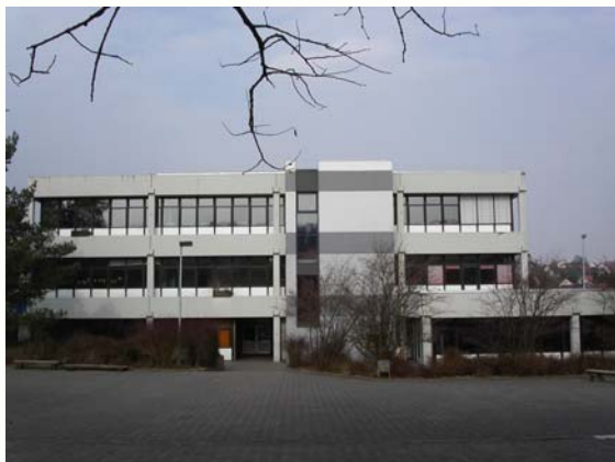
Gesamtschule Niederaula vor der Sanierung...
