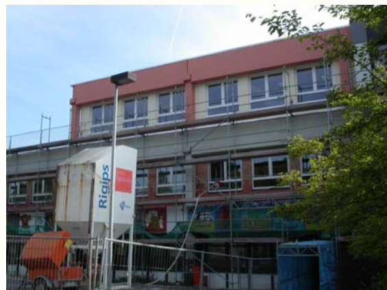
...und während der Sanierung
