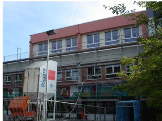
...und während der Sanierung
