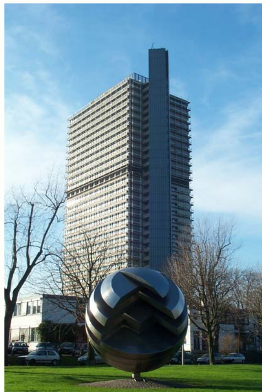
ehemaliges Abgeordnetenhaus „Langer Eugen, Sanierung und Umbau für die UN, Fertigstellung 2004
