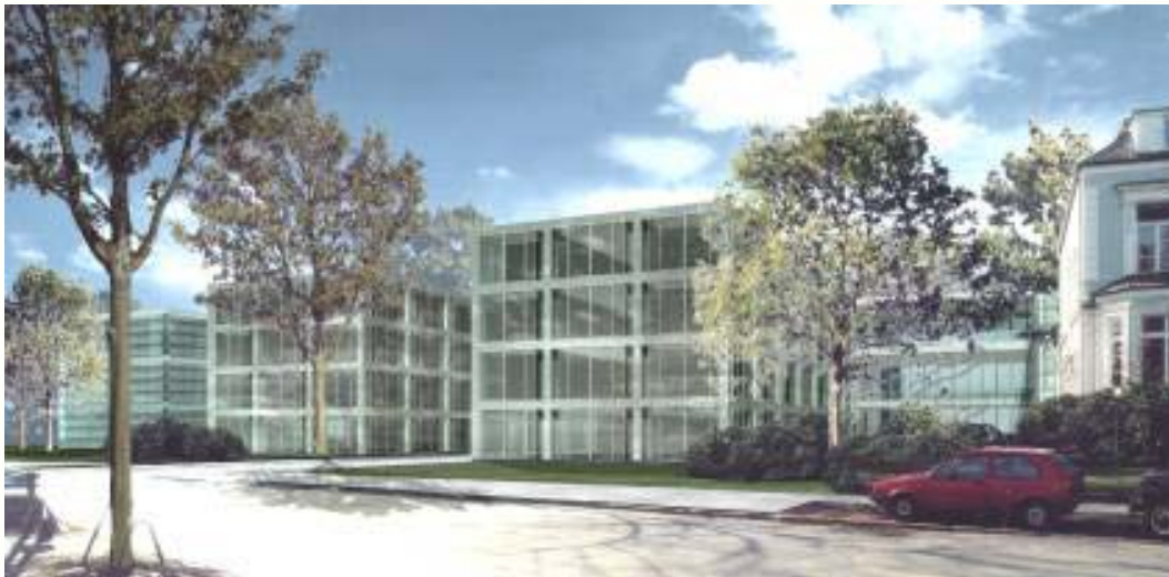
Neubau Hörfunk NDR, 1. Bauabschnitt Hamburg Architekten Schweger + Partner, Hamburg
